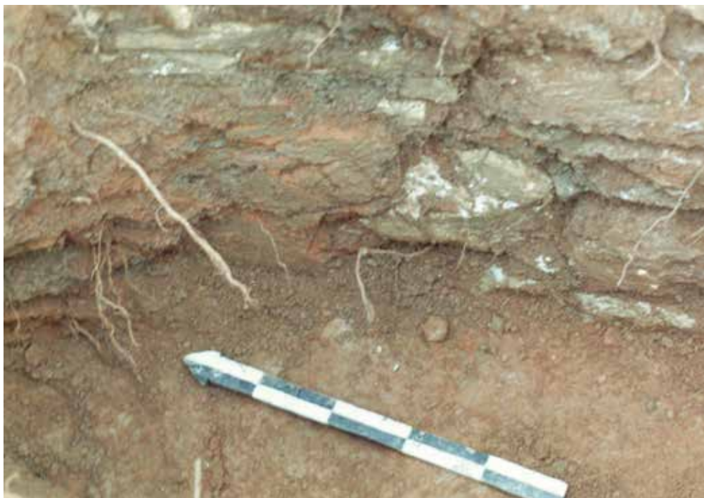
Εικ. 8. Επίχρσμα στον τοίχο του υπογείου.
