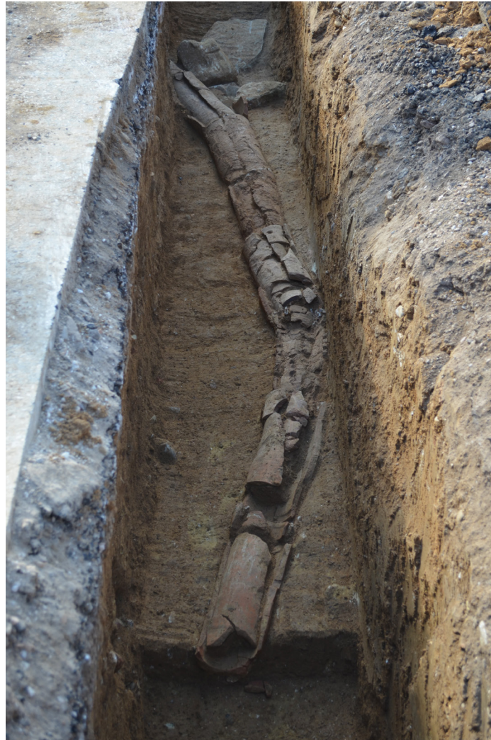
Εικ. 58. Θέση 11γ. Κλειστός υδροδοτικός αγωγός επί της οδού Πατρών-Πύργου. Άποψη από Β.
