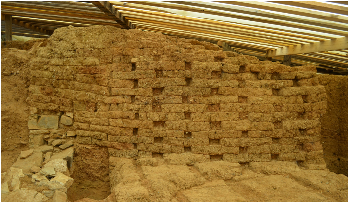
Εικ. 9. Θέση 1, τμήμα Α. Με τη χρήση ημιπλινθίων τοποθετημένων δρομικά στα άκρα σε εναλλασσόμενες σειρές οι κατακόρυφοι αρμοί διχοτομούν τις ωμοπλίνθους της υπερκείμενης και της υποκείμενης στρώσης. Άποψη από Α.
