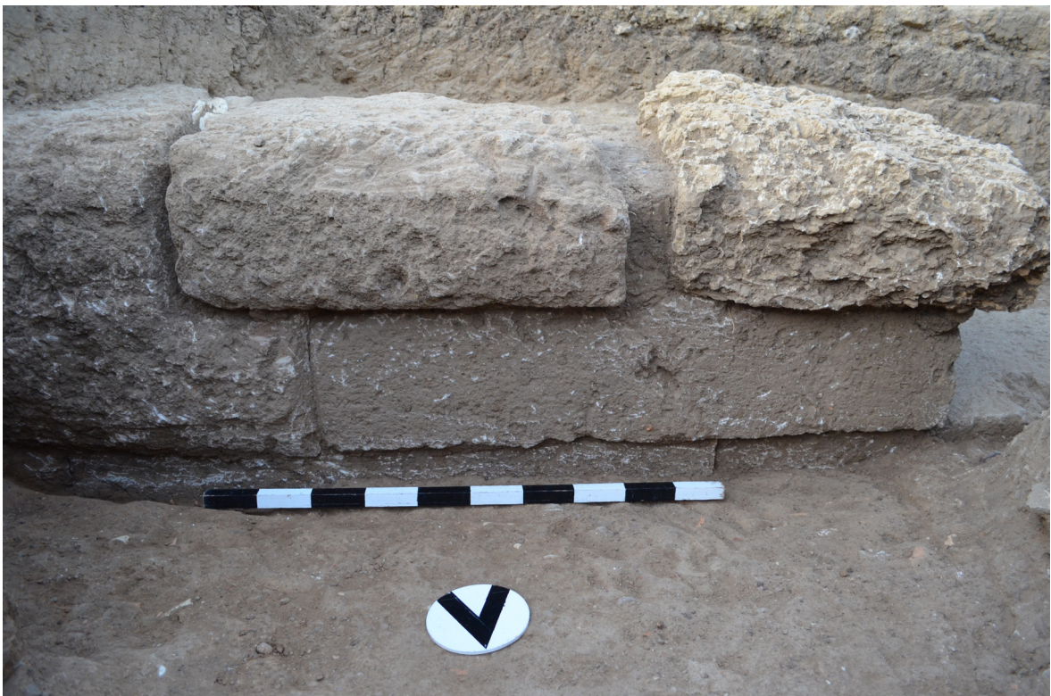
Εικ. 83. Ανάλημμα. Στο δυτικό ορατό τμήμα εντοπίστηκε άνοιγμα το οποίο σε μεταγενέστερο χρόνο καλύφθηκε με δύο ογκόλιθους. Άποψη από Β.
