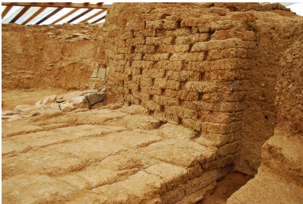
Εικ. 10. Θέση 1, τμήμα Α. Τμήμα της εξωτερικής όψης του πλίνθινου κορμού. Άποψη από ΒΑ.
