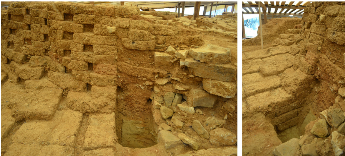
Εικ. 7. Θέση 1, τμήμα Α. Ο πλίνθινος κορμός θεμελιώνεται σε τάφρο ανεξάρτητη του λίθινου μετώπου που τον πλαισιώνει εσωτερικά. Λεπτομέρεια της επιφάνειας έδρασης. Άποψη από ΝΔ.
