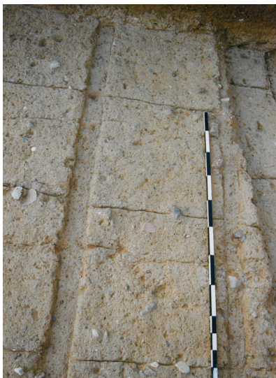
Εικ. 49. Θέση 10. Ο κορμός του τείχους κτισμένος με ωμές πλίνθους πλευράς 0,47 μ. Λεπτομέρεια.
