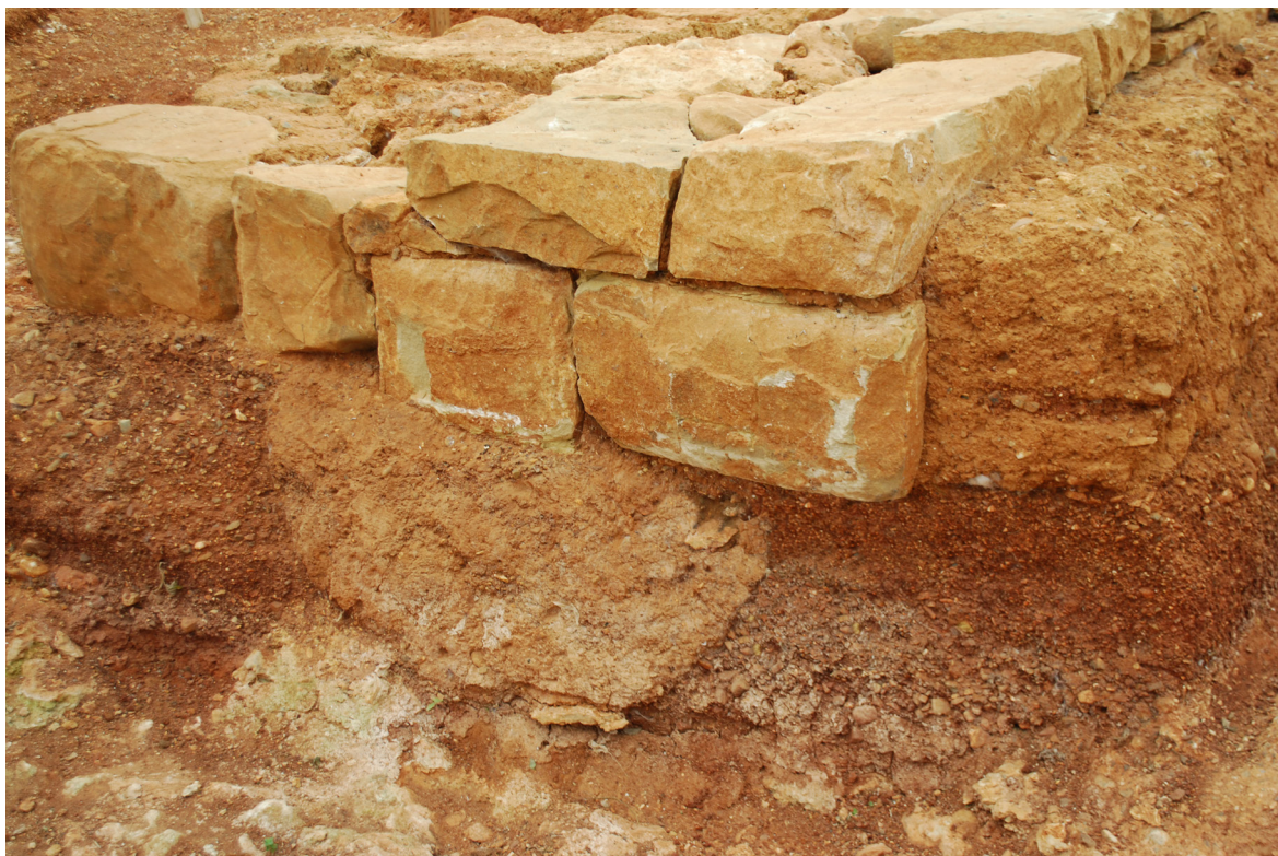
Εικ. 16. Θέση 1, τμήμα Β. Κάτωθεν του δυτικού μετώπου διακρίνεται προγενέστερη αύλακα. Άποψη από Δ.
