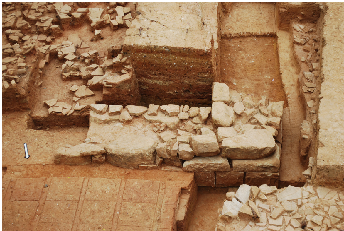
Εικ. 72. Θέση 15α. Μεταξύ του αμιγούς πλίνθινου κορμού και του βόρειου μετώπου του πύργου υπάρχει κατασκευαστικός αρμός. Ο πύργος προβάλλει του εσωτερικού μετώπου του τείχους κατά 1,20 μ. Άποψη από Β.
