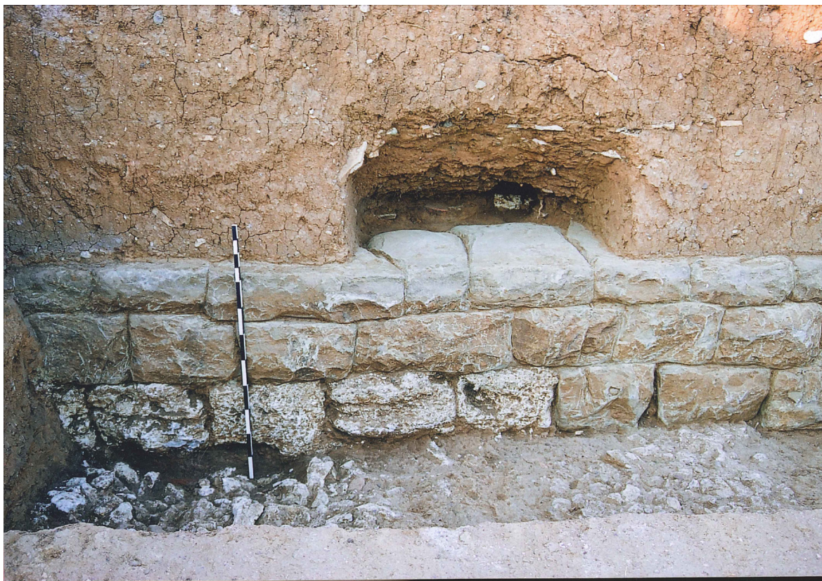
Εικ. 50. Θέση 10. Στο θεμέλιο του διαπιστώθηκε η χρήση δόμων ασβεστόλιθου σε β' χρήση και στο επίπεδο της θεμελίωσης στρώμα λατόμης που σηματοδοτεί την επί τόπου επεξεργασία των λίθων. Στην παρειά διακρίνεται μικρό τμήμα του λίθινου μετώπου της α' κατασκευαστικής φάσης. Άποψη από Δ.
