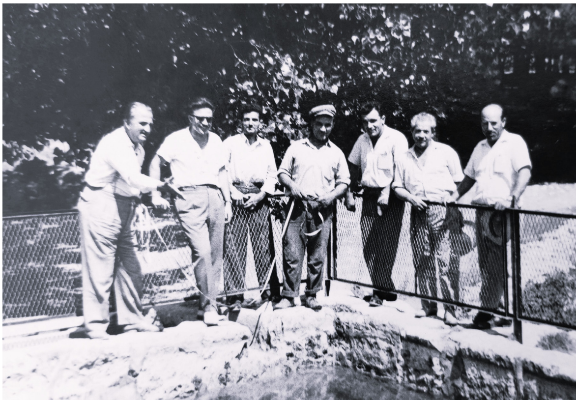
Εικ. 17. Το προστατευτικό κιγκλίδωμα στο χείλος της δεξαμενής δεκαετία 1960 (Αρχείο Γιαννούλας Βογιατζή).
