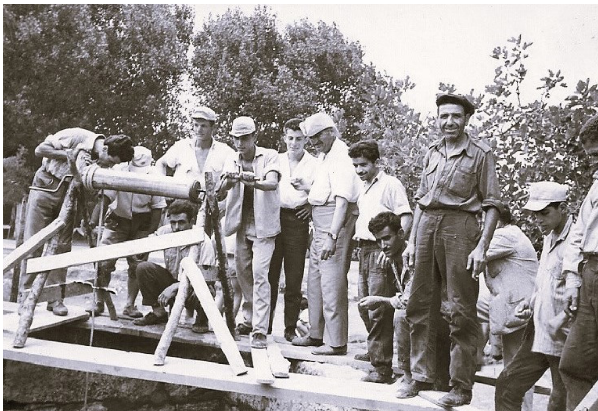
Εικ. 6. Καθαρισμός της δεξαμενής, 08.07.1959 (Αρχείο Στέλλας Λαζαρίδου- Παπαδοπούλου).
